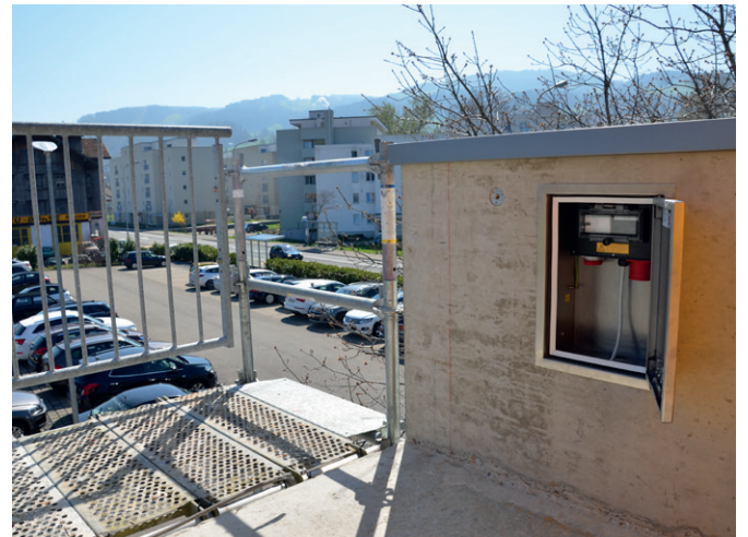
Distributore sotto muro incassato non ingombrante
