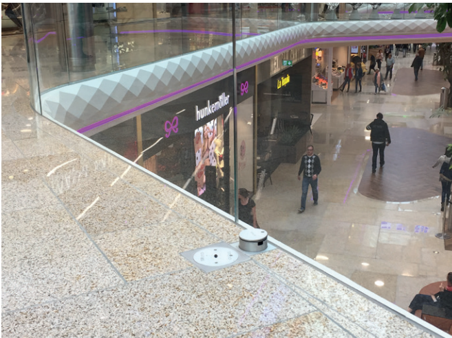
Presa da pavimento Fonto e Masso, Centro commerciale Plus City
